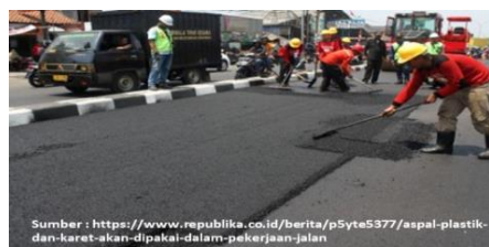
Gambar 2.6. Pelaksanaan Pekerjaan Jalan Menggunakan Limbah Plastik (Putri, 2018)
