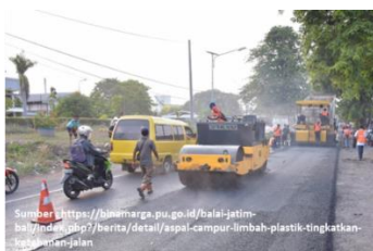
Gambar 2.6. Pelaksanaan Pekerjaan Jalan Menggunakan Limbah Plastik (Putri, 2018)
